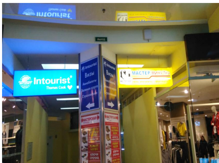
Рисунок 2 - Размещение светового пожарного оповещателя «Выход» в торговом центре «Атмосфера» г. Санкт-Петербург
