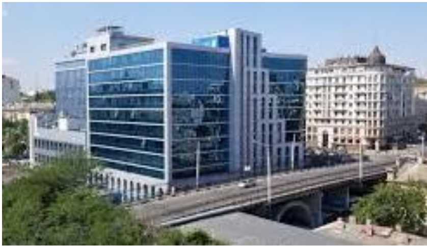
Рис. 4. Тильний 13-поверховий вигляд будівлі бізнес-центру з боку Деволановського узвозу і Строганівського мосту (вул. Грецька)
