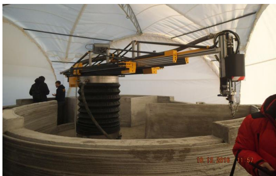
Рис. 3. Принтер Apis Cor, що працює в кутових координатах
