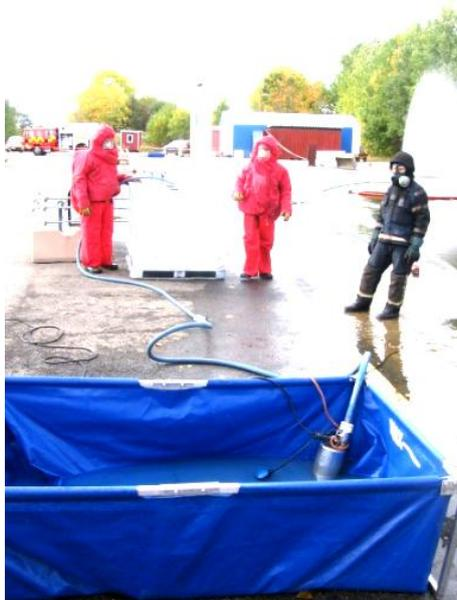
Рисунок 2 - Перекачка конденсата жидкости в аварийную емкость
