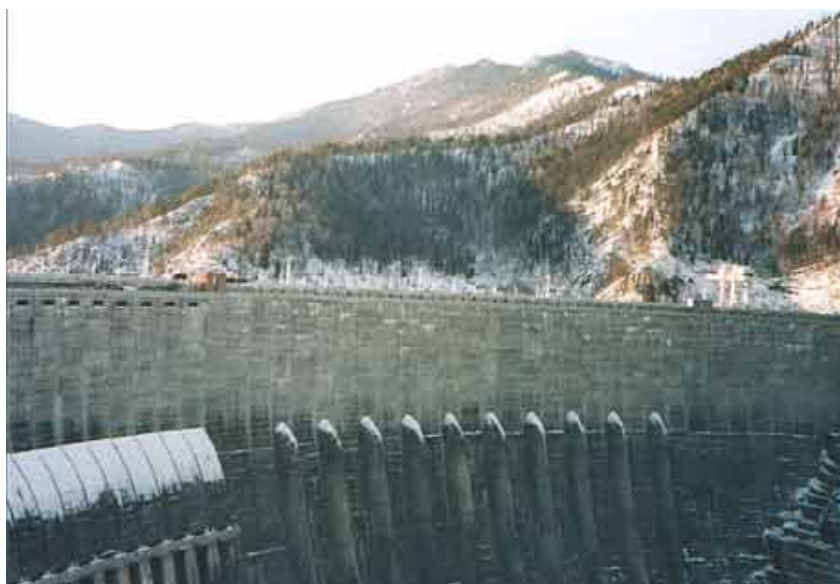
Рис. 1.18 – Плотина Саяно-Шушенской ГЭС
