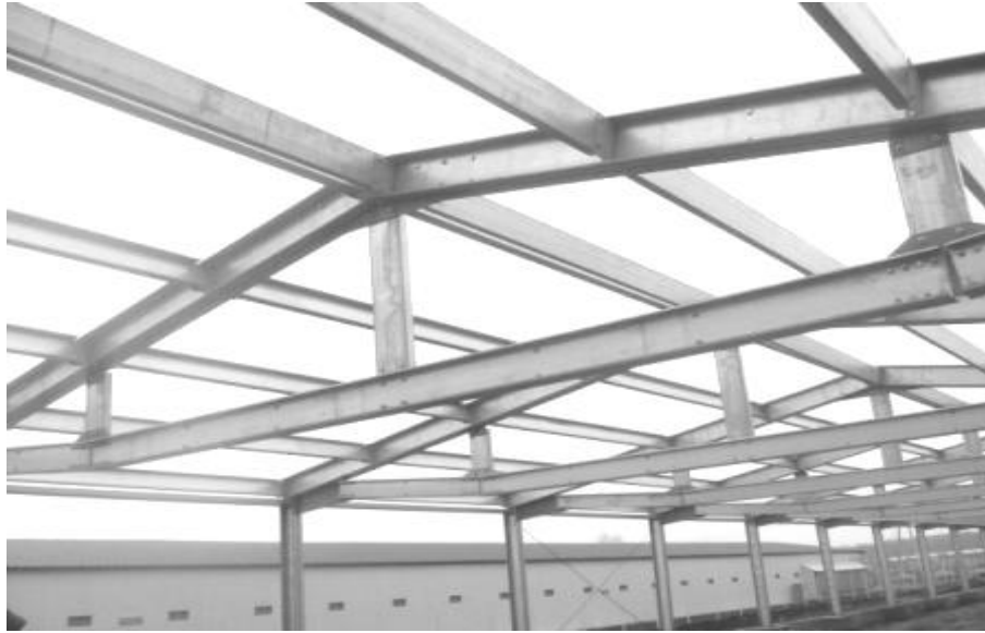
Рис. 1. Загальний вигляд металевої ферми.
