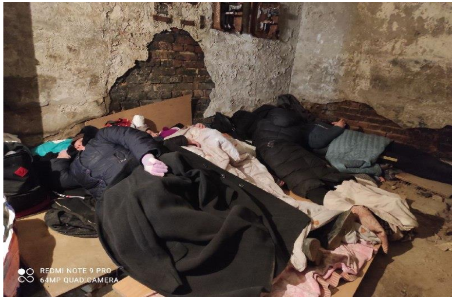
Рис. 1 Стан приміщення, яке слугувало укриттям для людей на початку війни, через відсутність поряд підготовлених укриттів.
