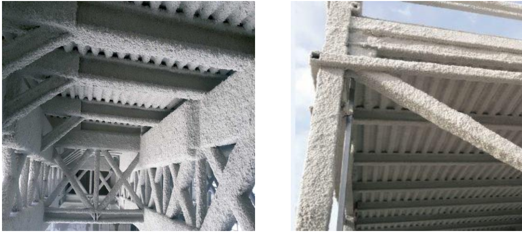
Рисунок 2 – Металеві будівельні конструкції оброблені штукатурним вогнезахисним покриттям
