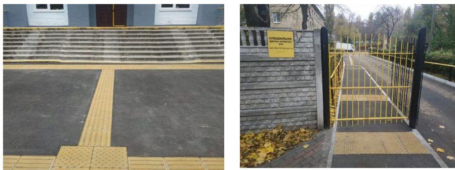
Рисунок 1 – Приклади облаштування тактильної плитки та світловідбиваючого маркування
