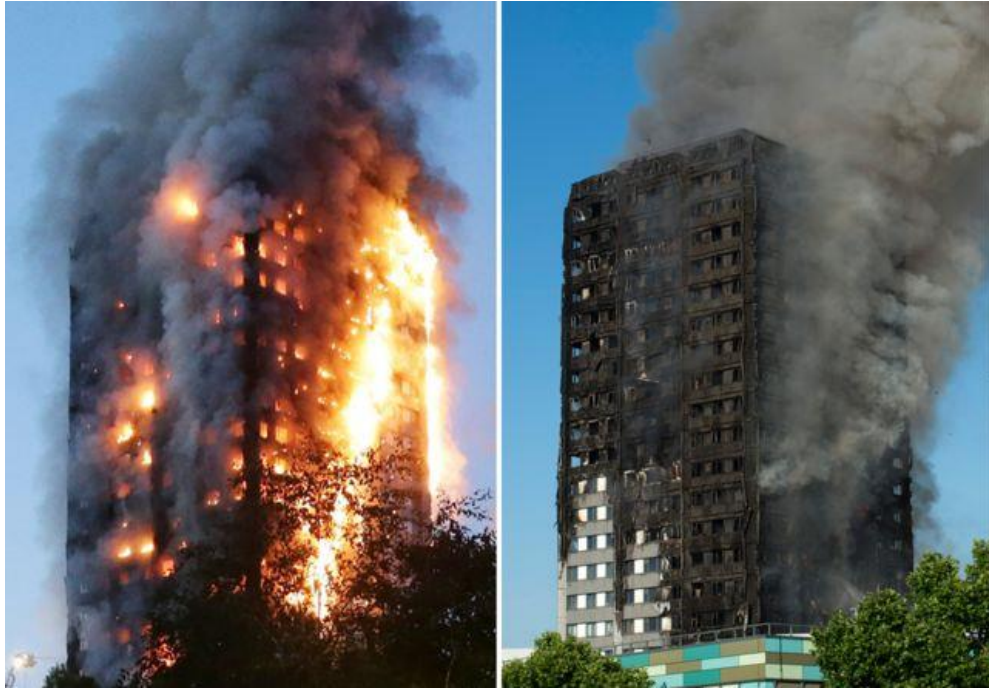
Рис. 1. Пожежа в будівлі Гренфелл-Тауэр, Лондон (Великобританія).
