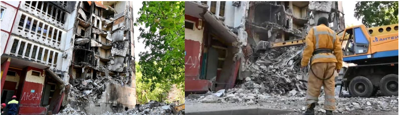
Рисунок 1 – Пошкоджена будівля на Північній Салтівці
