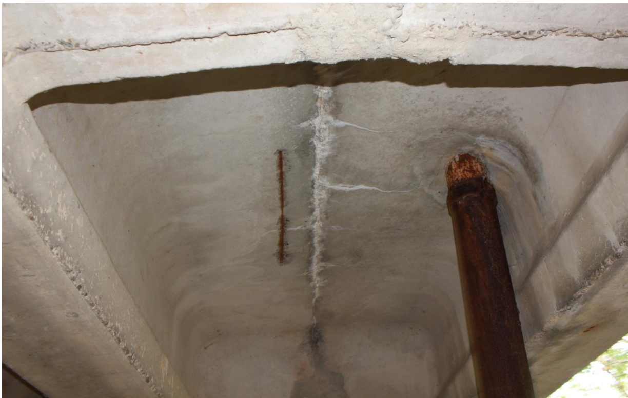
Рисунок 4 – Руїнування водовідвідних трубок
