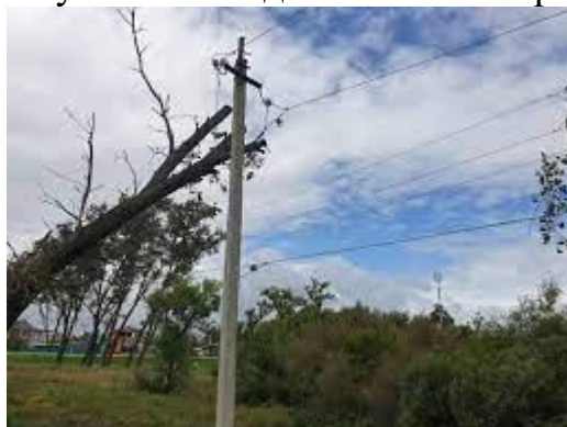
Рисунок 6. Падіння дерева на провід повітряної лінії.
