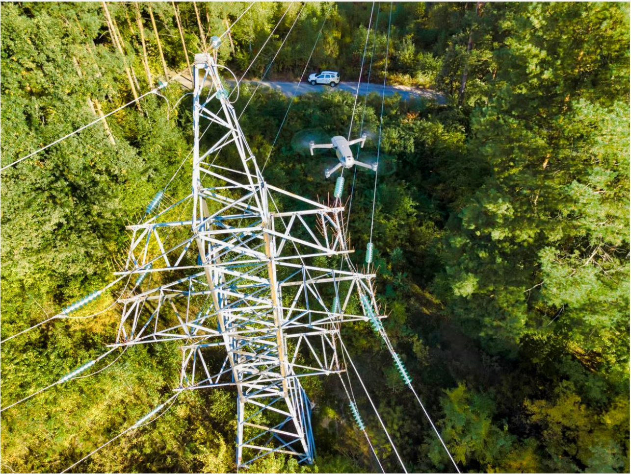
Рисунок 1. Обстеження мереж за допомогою дрона
