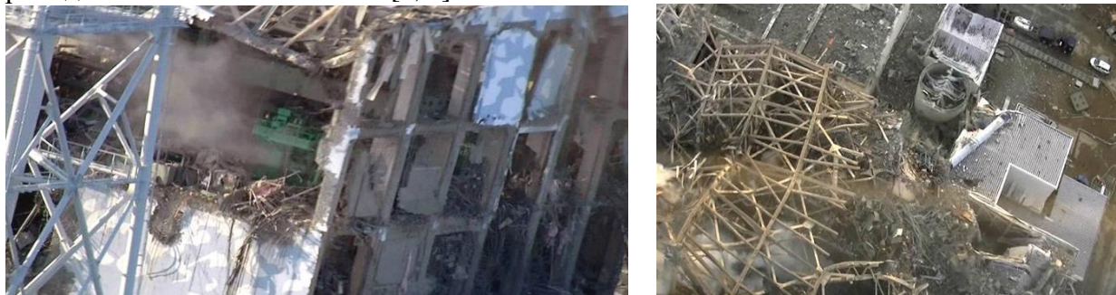
Рис. 1. Фото руйнувань на АЕС "Фукусіма-1".
