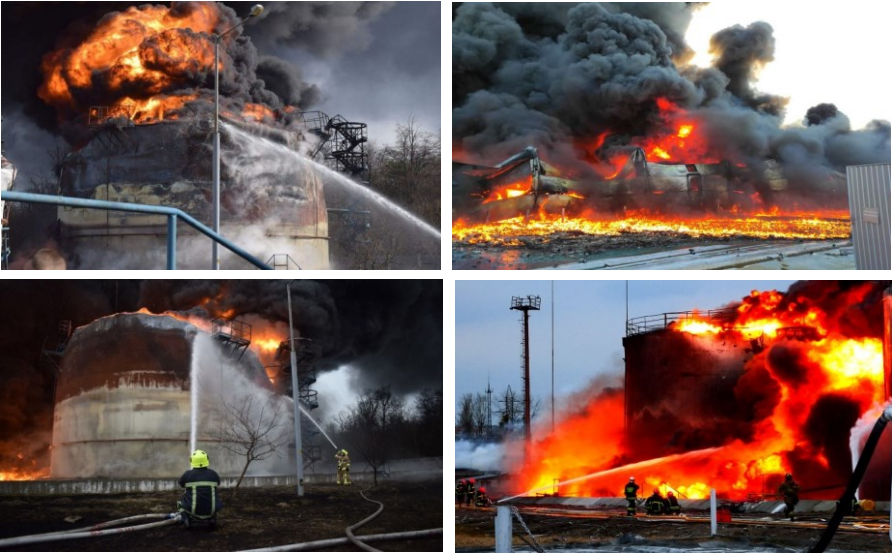
Рис. 2.3. Обстановка пожеж на нафтобазі внаслідок обстрілів
