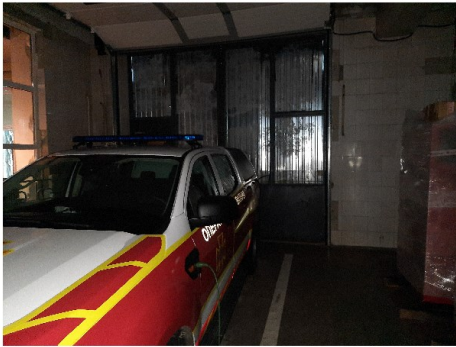
Рис. 6.7. Стан воріт після обстрілу прилеглої території (скло замінено профнастилом). Приклади розміщення оперативних транспортних засобів задньою частиною вбік воріт
