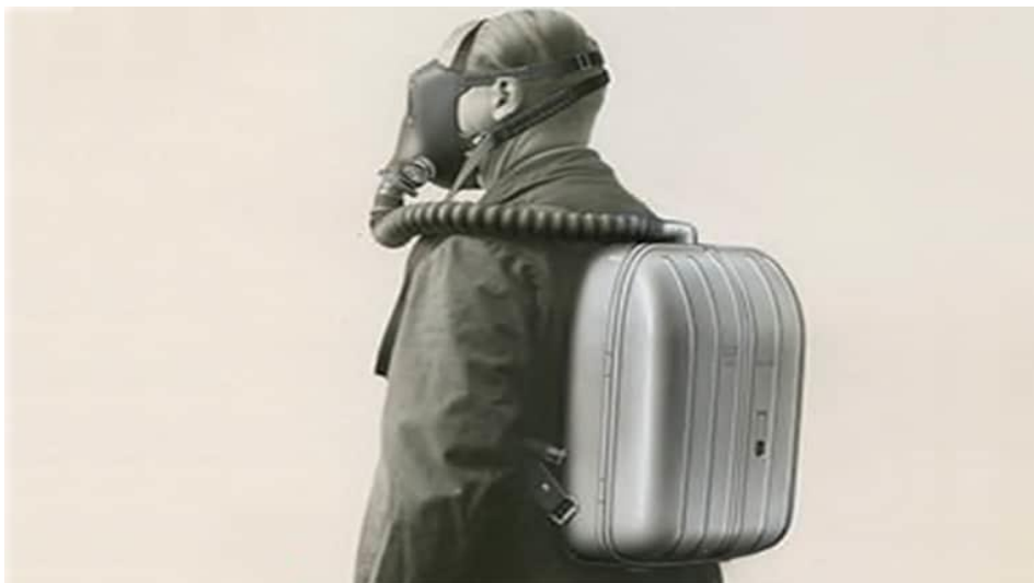
Рис. 1. Перший дихальний апарат зі стисненим повітрям Dräger Modell 10
