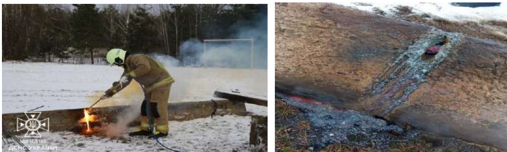
Рис. 1. Робочий момент різання бетонних конструкцій та зовнішній вигляд бетонних конструкцій після роботи апарату.
