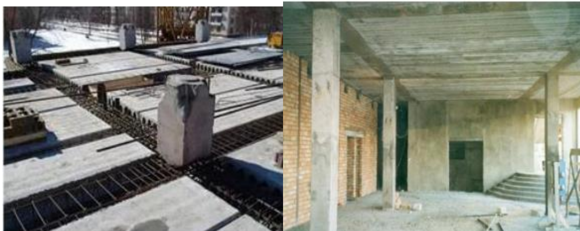
Рис. 4 Монолітно-каркасна будівля системи «АРКОС» [6]
