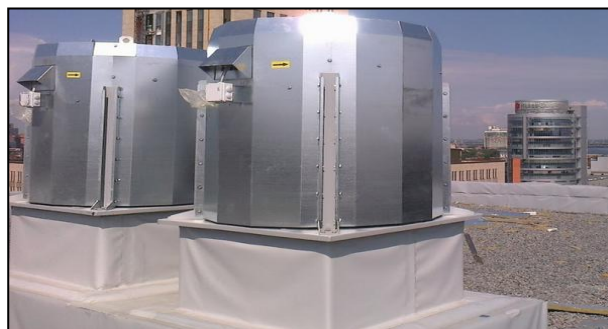
Рис. 3.7 – Системи механічного димо-та тепловидалення
