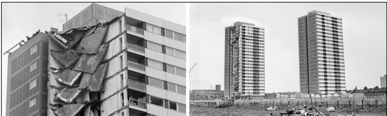
Рис. 2.1 – 16 травня 1968 рік, Лондон, наслідки ефекту прогресуючого обвалення конструкцій житлового будинку після вибуху побутового газу в одній із квартир
