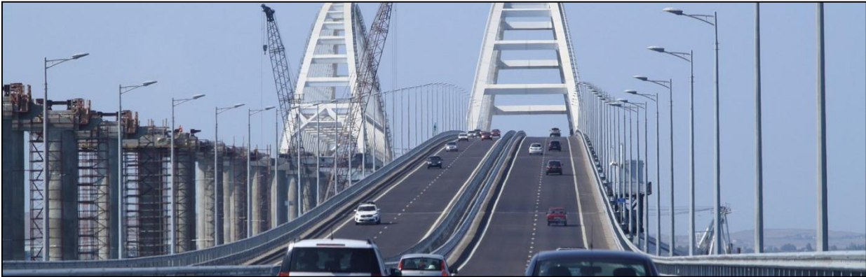
Рис. 4.2 – Автоматизовані системи раннього виявлення загрози виникнення надзвичайних ситуацій та оповіщення населення встановлені на деяких мостах
