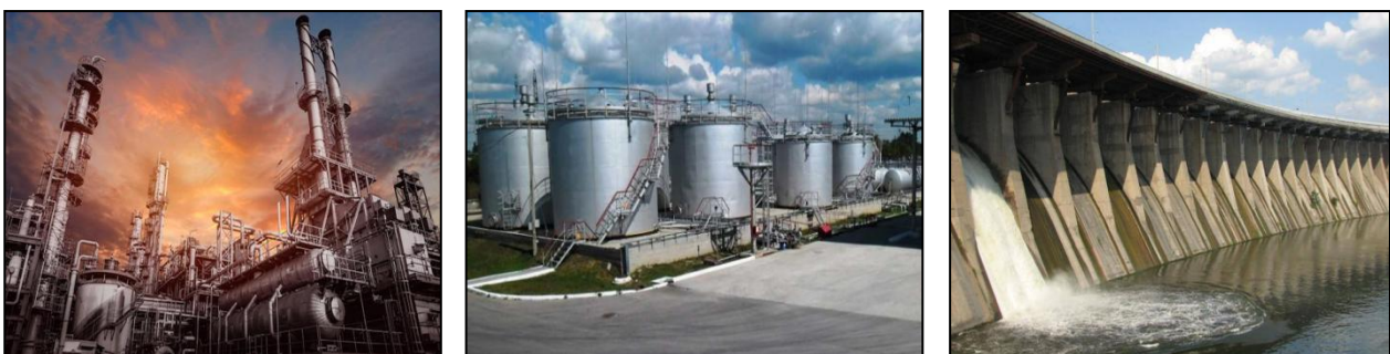
Рис. 4.1 – Приклади об'єктів які підлягають обладнанню автоматизованими системами раннього виявлення загрози виникнення надзвичайних ситуацій та оповіщення населення
