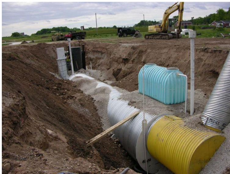
Рисунок 1. – Приклад використання металевих аркових безкаркасних конструкцій в укриттях цивільного захисту
