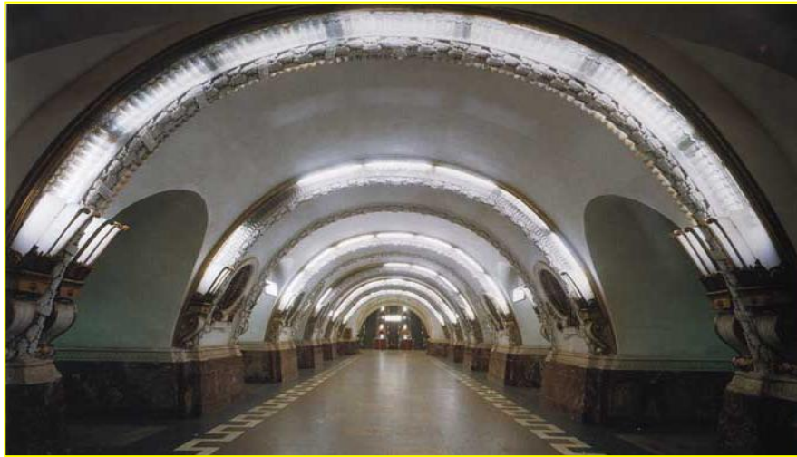
Рисунок 7.14 – Застосування залізобетону при будівництві метрополітенів
