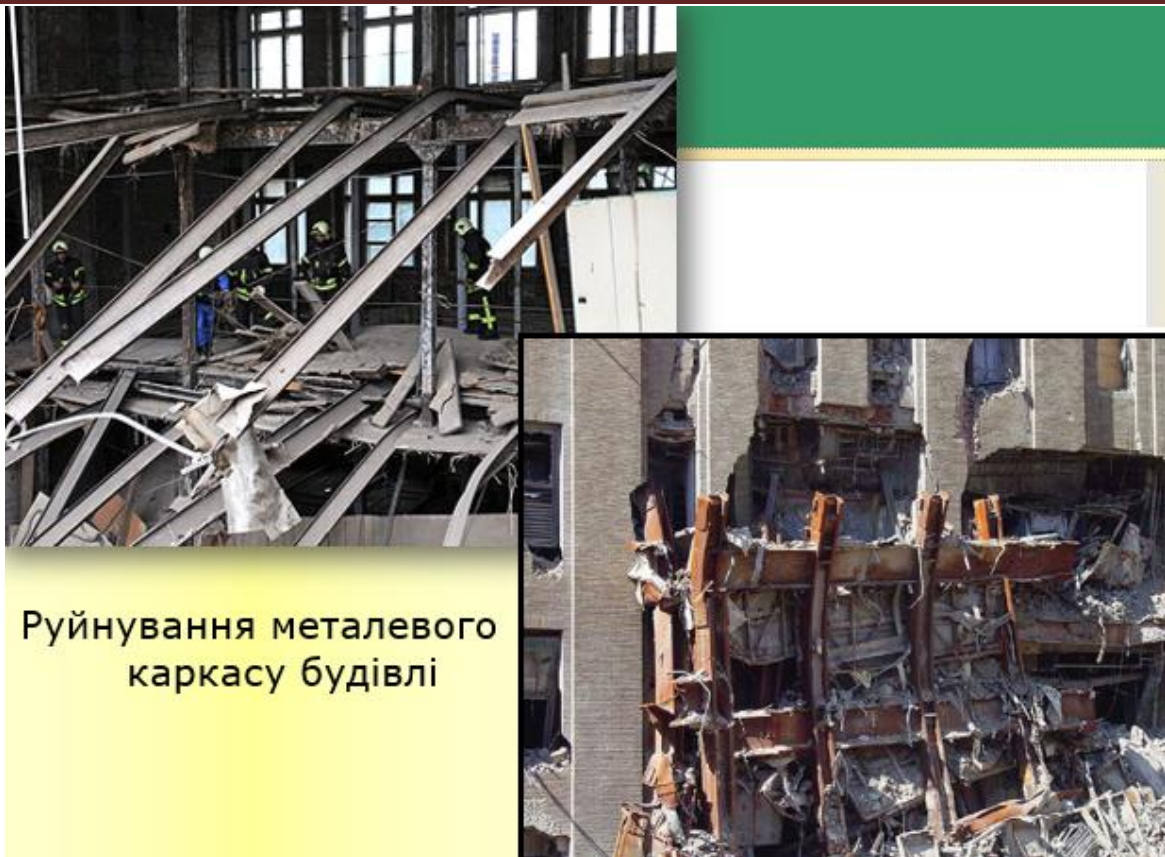
Рисунок 1.9 – Руйнування металевого каркасу будівлі
