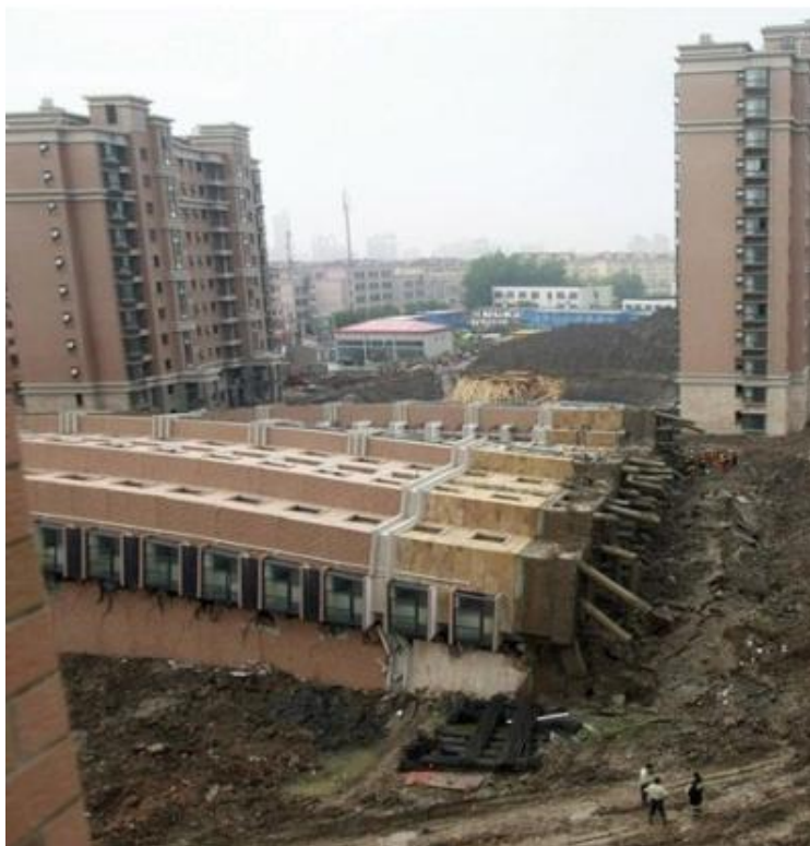
Рисунок 1.6 – Наповнення водою основи та тиск ґрунту
