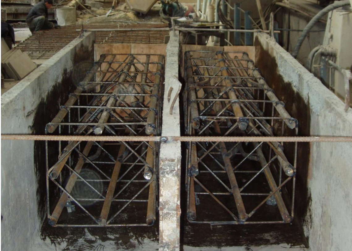
Рисунок 13.1 – Встановлення арматури в опалубку колон
