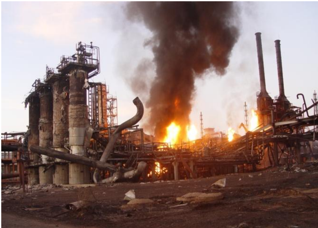
Рисунок 3.5 – Руїнування конструкцій споруд від пожежі
