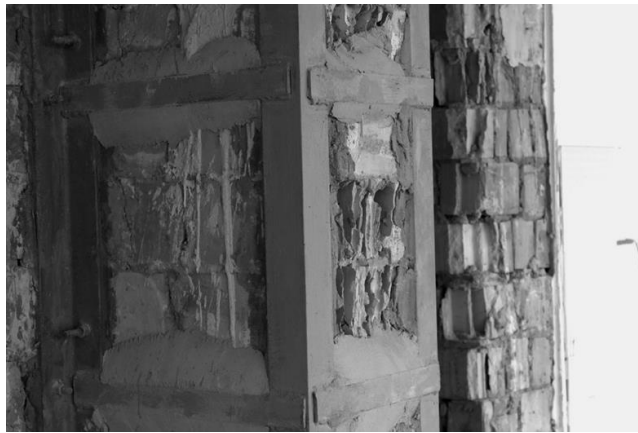
Рис. 1. Приклад встановлення підсилення
