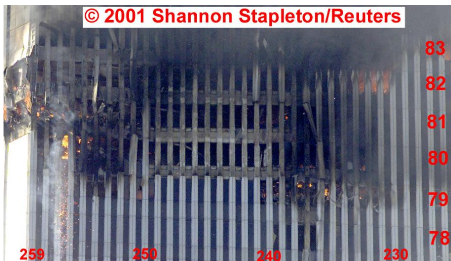
Рисунок 5 - Повреждения огнезащиты колонн наружной оболочки ТЦ-2 после взрыва топлива в зоне удара самолета во время событий 11 сентября 2001 года
