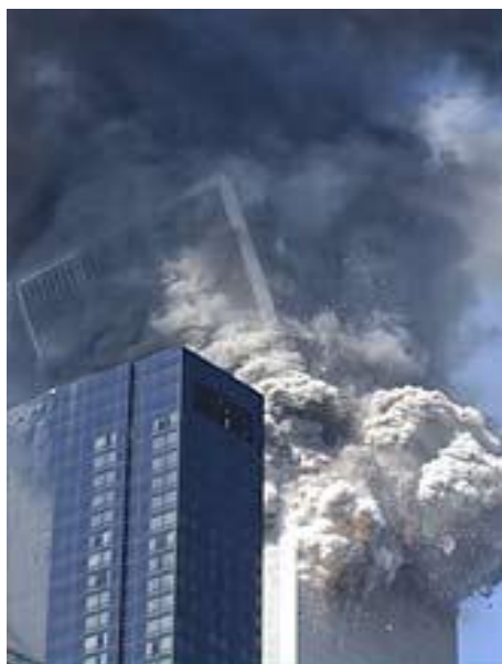
Рисунок 3 - Начало прогрессирующего обрушения Южной башни ВТЦ – 2 во время событий 11 сентября 2001 года
