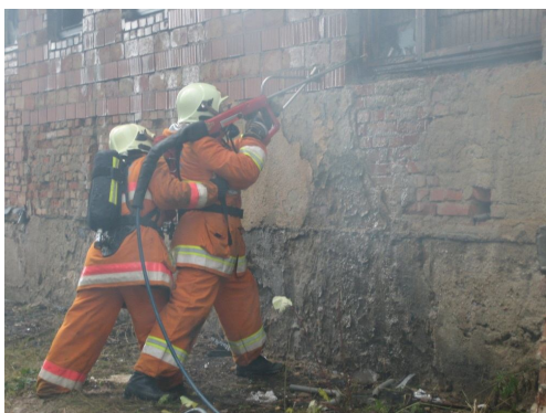
Рис. 1. Установка холодной резки «Cobra»
