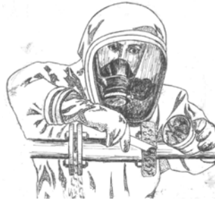
Рис. 3 – Герметизація фланцевих з'єднань
