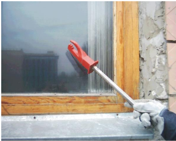
Рис. 4.20. Виготовлення отворів за допомогою інструменту ІРАР
