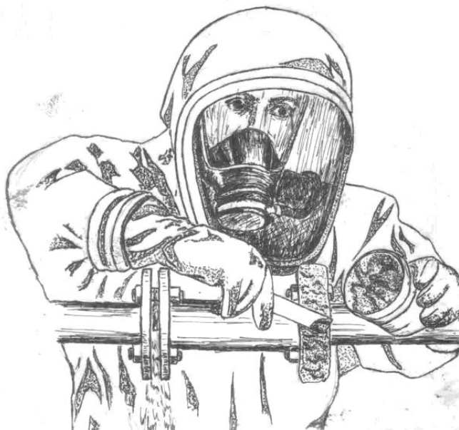
Рис. 5.8. Герметизація фланцевих з'єднань
