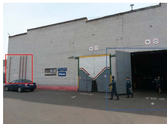
Рисунок 8 – Начало проведения обследования объекта
