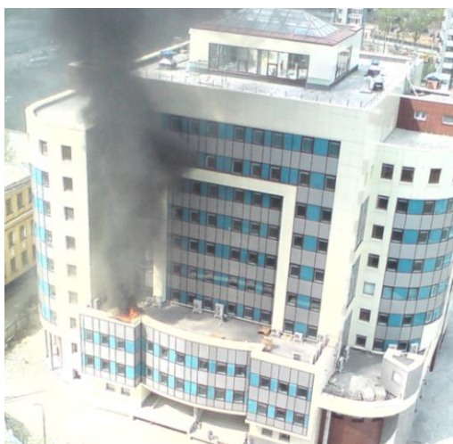
Фото 1. Начальная стадия пожара (снимок сделан рабочим с соседнего здания).
