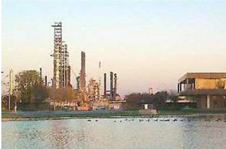
Рис.2.22 — Установка каталітичного риформінгу з безперервною регенерацією каталізатора. Реактори розташовані на етажерці вертикально, один над одним
