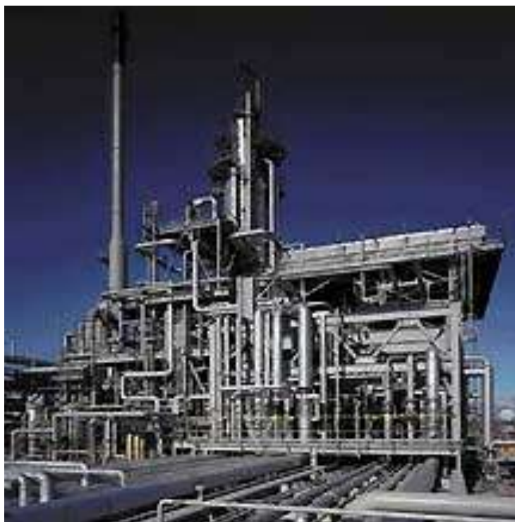
Рисунок 2.23 — Установа гідроочистки дизельного палива: зліва видно пічну трубу; посередині – відгонну колону
