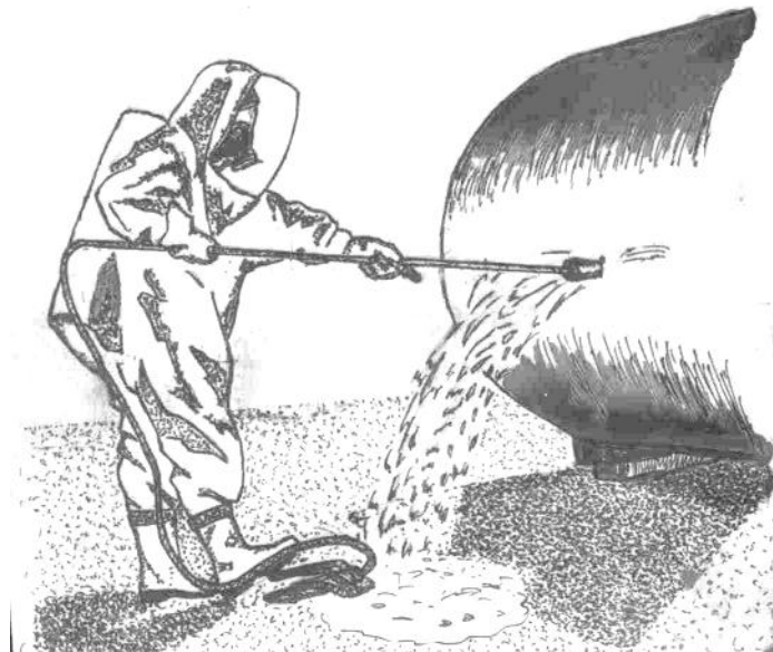
Рис. 3.9. – Затискання пробойни пневматичною заглушкою
