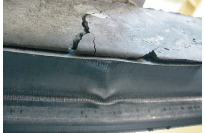
Рис. 6. Деформація крайньої гофри СПН
