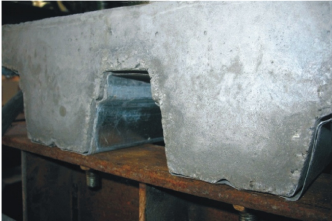
Рис. 5. Відшарування профільованого настилу
