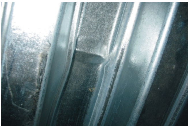
Рис. 8. Деформація верхньої полиці СПН плит серії П-I
