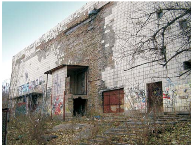
Рис. 2. Вигляд кладки стіни фасаду по осях 10–1
